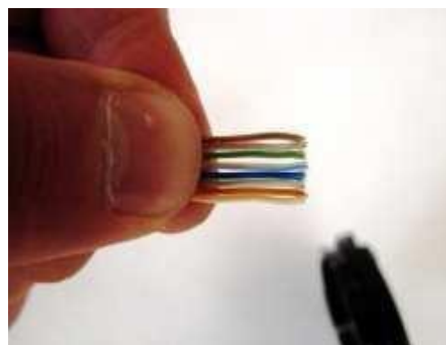
Рисунок3. Выпрямляем проводники
